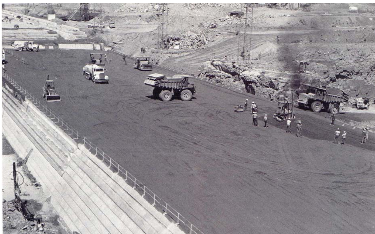
Slika 10. i 11. Ugradba UB na brani Upper Stillwater , SAD
