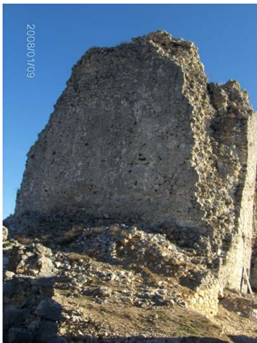
Pogled na sjeverozapadni zid kule „Heceguša“
