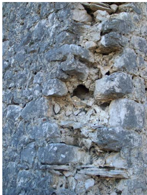
Otvori u zidu – mjesta na kojima su nekada bile drvene grede
