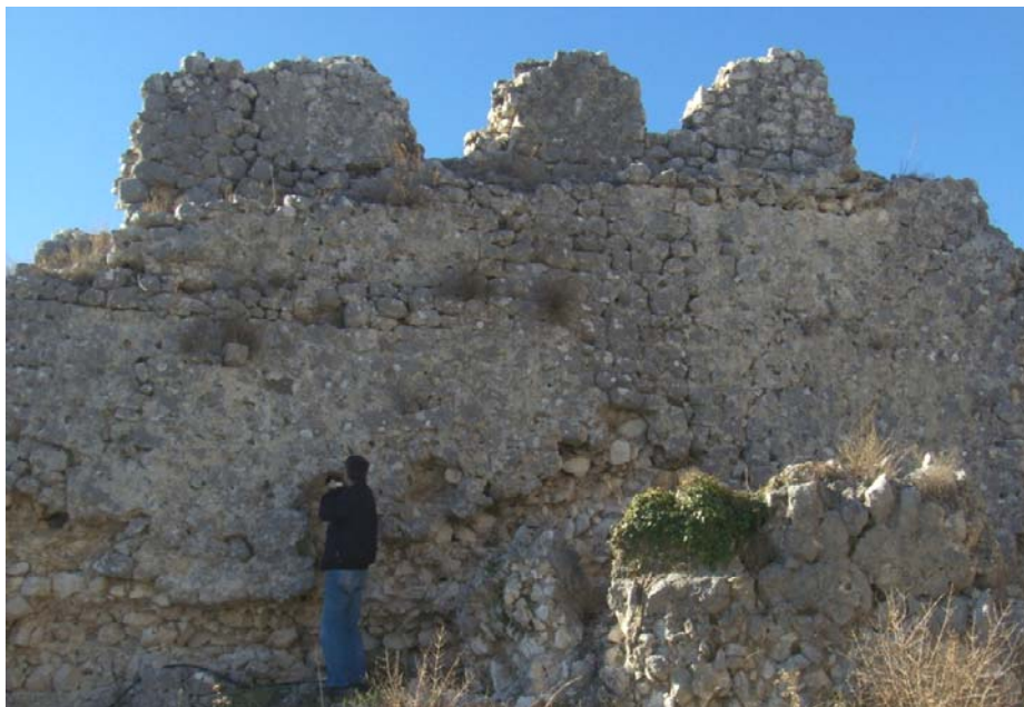
Dio zida Z1
