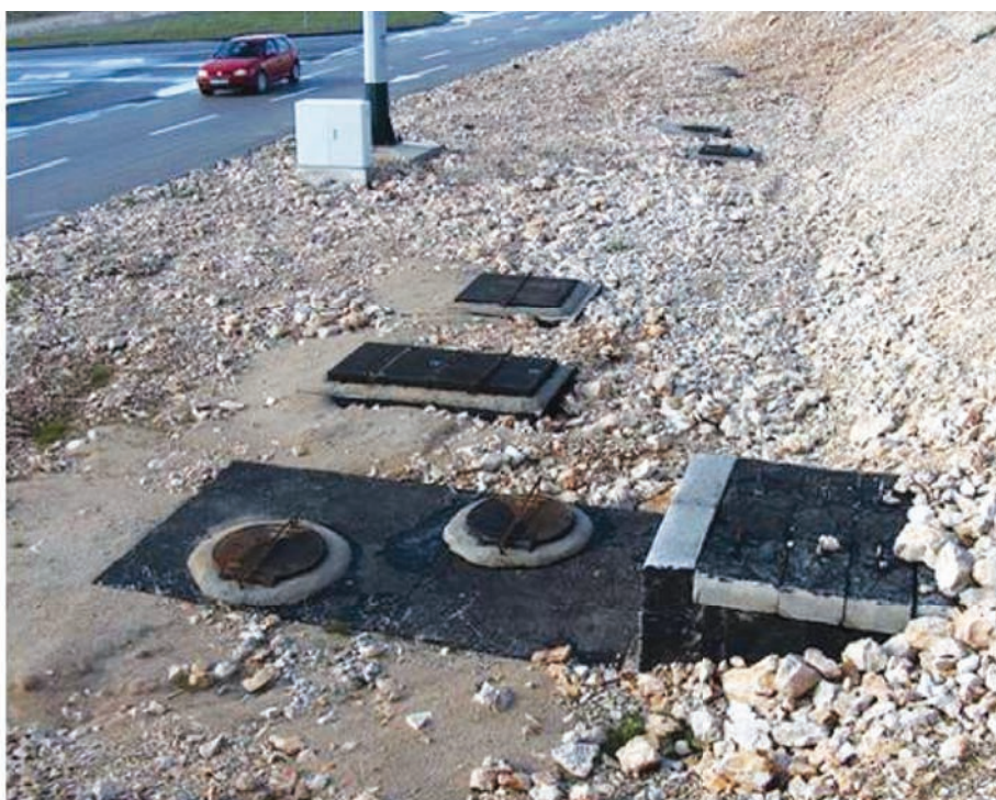
Slika 2. Separator otpadnih voda uz autocestu
