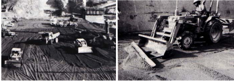
Sl. 1. Ugradba UB na brani Elk Creek , SAD (lijevo), s detaljom razastiranja kontaktnog morta (desno)
