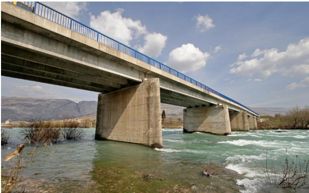
Slike 4.-5. Obnovljeni Avijatičarski most/ most Franje Blaževića
