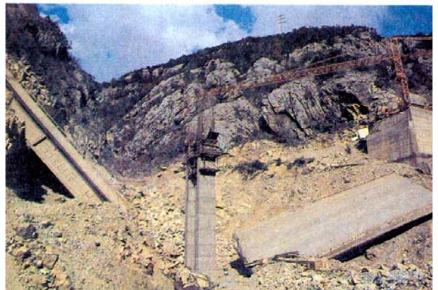
Slika 23. Početak obnove mosta „Jasen“
