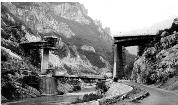
Slika 6. Gradnja novog cestovnog mosta kod Aleksinog Hana 1968. godine (pogled nizvodno)
