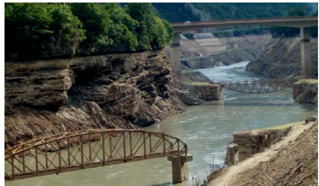
Slika 8. Mostovi na Aleksinu Hanu (foto iz 2005. godine s ispražnjenom akumulacijom HE Grabovica zbog radova na elektrani. Oba željezna mosta su permanentno potopljena: uskotračni željeznički i cestovni)
