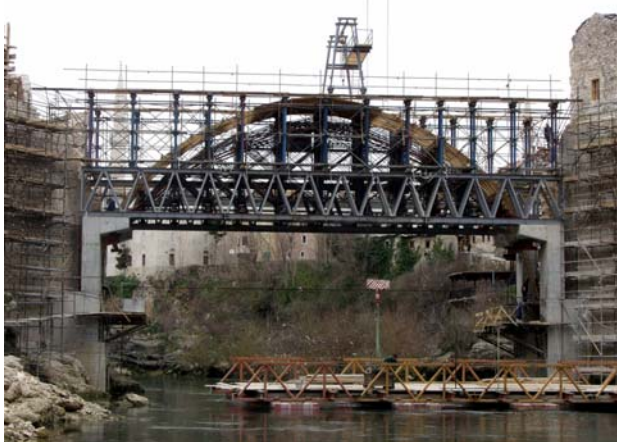
Slika 23: Čelična skela luka Starog mosta (Foto: Omega engineering)
