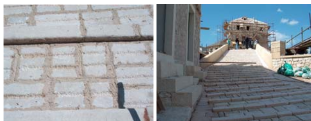
Slike 29.-32. Faze ugradnje kaldrme Starog mosta (I.-III. 2004. – foto: IGH-MOSTAR)
