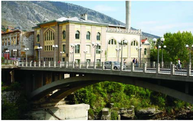
Slika 19. Obnovljeni most Musala
