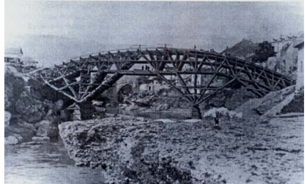
Slika 20. Skela za izgradnju Lučkog mosta (snimio M. Loose) [7]
