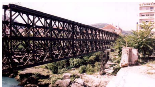
Slika 18. Željezna konstrukcija privremenog mosta (1994)
