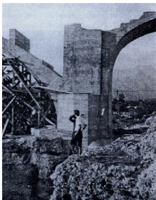
Slika 26. Početak gradnje Carinskog mosta (snimio M. Loose) [7]
