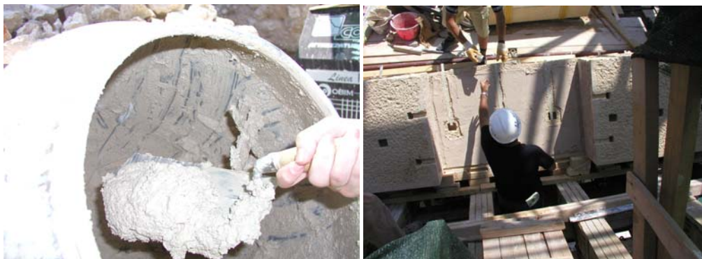
Slike 8.-9. Izgled gradilišnog miksa morta – homogenost i «plastičnost» morta (lijevo); izgled gradilišnog miksa morta – ugradljivost morta za zidanje (desno)
