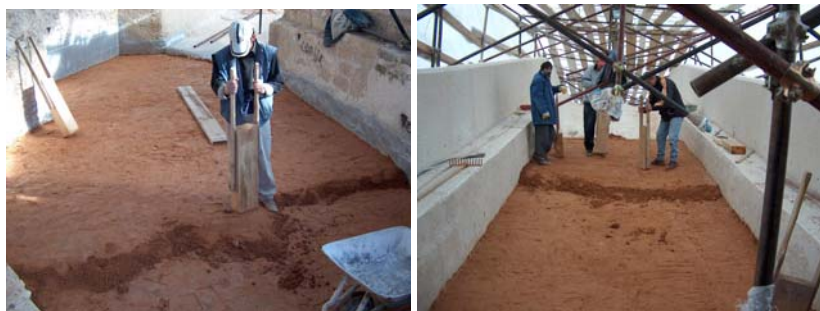
Slike 11.-12. Zbijanje crvenog morta u slojevima
