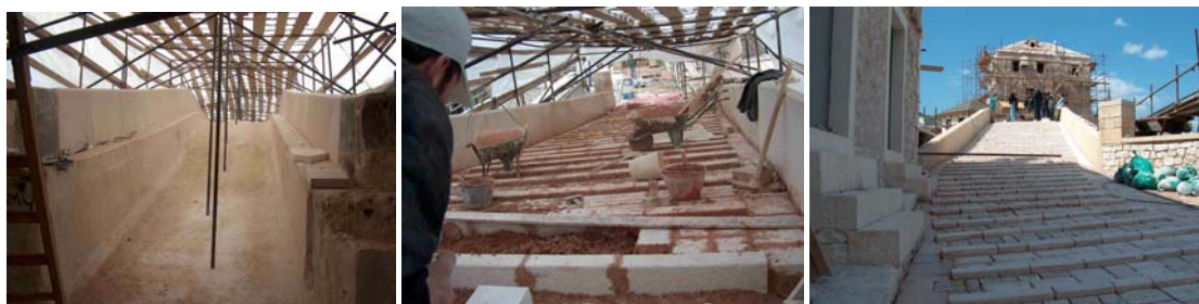
Slike 1.-3. Faze ugradnje kaldrme Starog mosta u Mostaru
