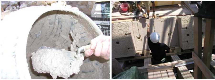
Slike 34.-35. Izgled gradilišnog miksa morta – homogenost i «plastičnost» morta (lijevo); izgled gradilišnog miksa morta –ugradljivost morta za zidanje (desno)
