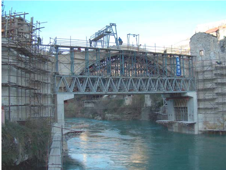
Slika 1. Stanje obnove Starog mosta u Mostaru krajem 2003. godine
